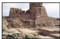
Vue générale du chantier de l'Acropole I, 1969. (Cote : JP40311)
